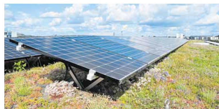
Kombinationen aus Gründach und PV-Anlage erfordern gute Planung und die Zusammenarbeit mehrerer Gewerke. Foto: Bundesverband GebäudeGrün e.V.
